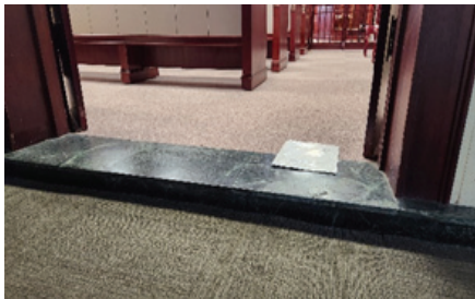
圖七、憲法法庭入口設有門檻，此高低差可能造成輪椅進入障礙。
